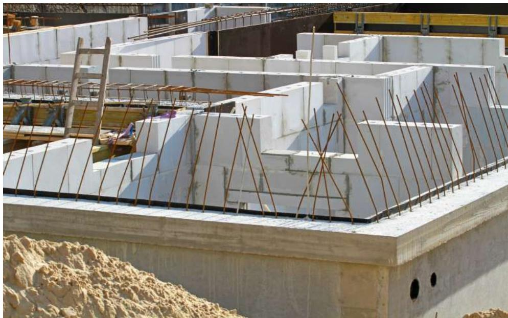
Die Kellerdecke wird als Filigrandecke mit Aufbeton und örtlich verlegter Bewehrung gemäß Statik ausgebildet.
